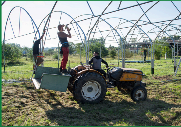
Le montage de la serre chapelle, une belle aventure...
